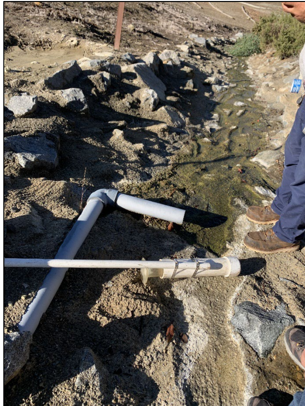
Photo 22) Right Groin Drain pipe (6/16/08 Drain pipe).
